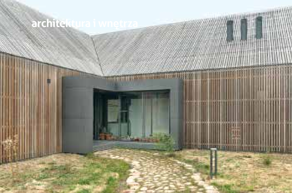
► Kamienna droga prowadzi do nowoczesnej, przeszklonej strefy wejścia w metalowej ramie
