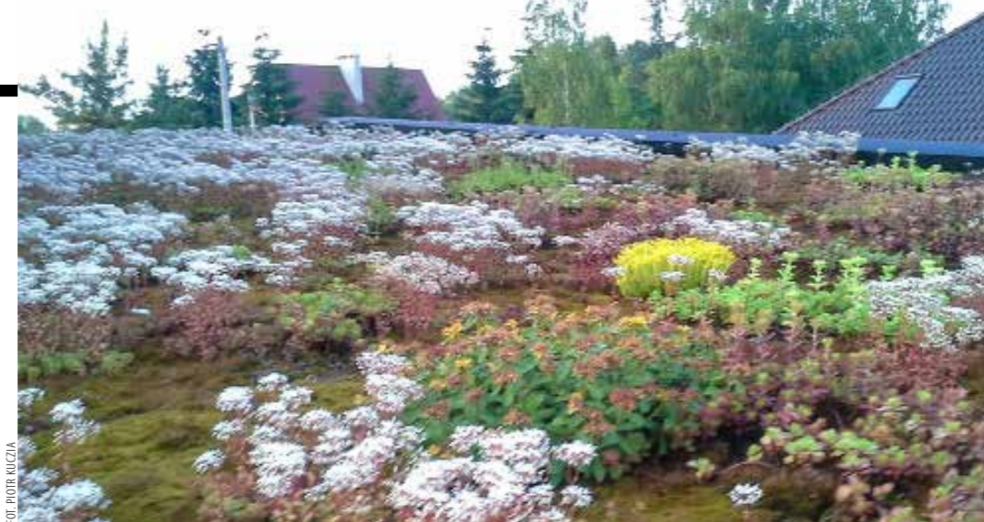
► Zielony dach na domku ekologicznym. Od kilkunastu lat nie wymaga praktycznie żadnej pielęgnacji (Dom nad Jeziorem Łąckim). Projekt: Piotr Kuczia
