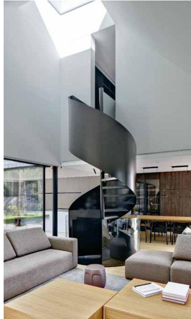
► Zaprojektowane przez PL.architekci stalowe kręcone schody łączą trzy kondygnacje i są architektoniczną rzeźbą w reprezentacyjnej części głównego poziomu
