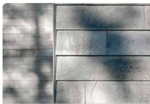
► Betonowe płytki pokrywające ściany są ułożone tak, że jedna nachodzi na drugą, tworząc pancierz chroniący mury przed niszczeniem w leśnym otoczeniu
